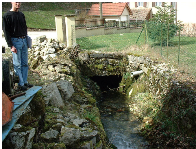
Amont du franchissement de la voie communale
