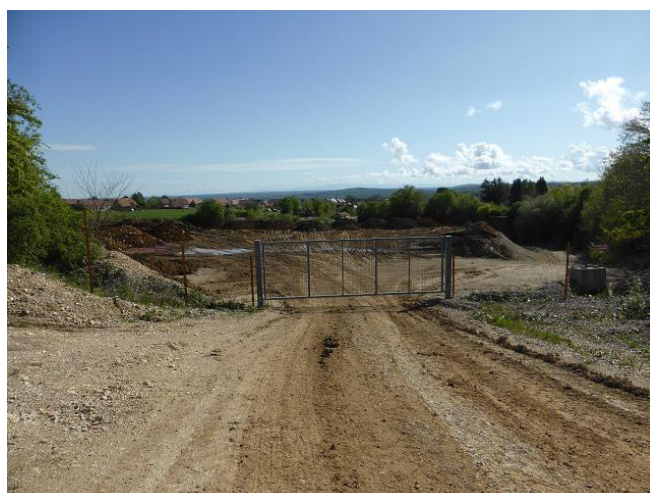
Zone de dépôt d'inertes
