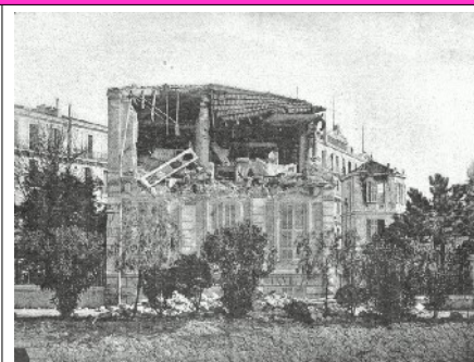
Destruction de bâtiments à Menton (06) suite au séisme de 1887 et à la liquéfaction des sols (Source : Les Tremblements de Terre - FA Fouqué)
