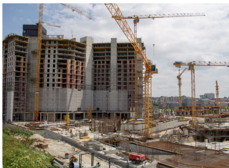
Chantier de construction
