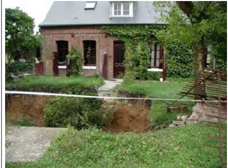
Conséquence d'un affaissement (Somme) – (Source : BRGM)
