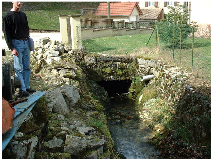
Amont du franchissement de la voie communale
